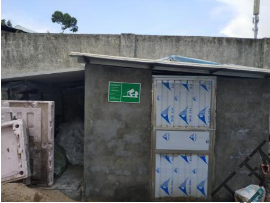
一般固废贮存场所
